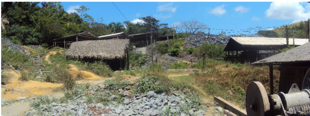
FIGURA 14.1.1-2 - Instalações de beneficiamento do minério primário de ouro no Garimpo do Galo envolvendo britagem, moagem e concentração em caixas.
